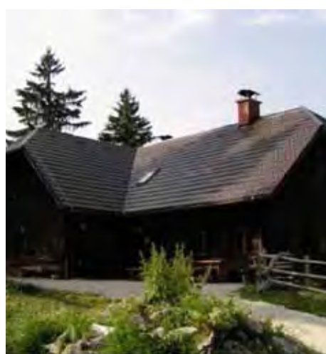
Koča v Grohotu pod Raduho ima novo streho in obnovljeno kotlovnico, foto arhiv PD Mežica
