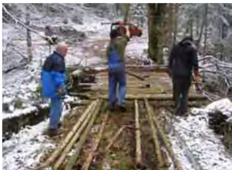
Popravljanje mostu, foto Alenka Hitti
