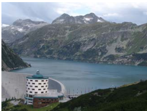
START PRI KÖLNBREINSPERRE
